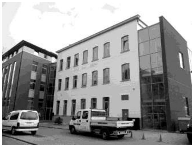
Le premier bâtiment de l'école des garçons le long de la rue Mazy aujourd'hui, après de multiples transformations, mais portant toujours l'inscription « Ecole Saint-Joseph » ↴
