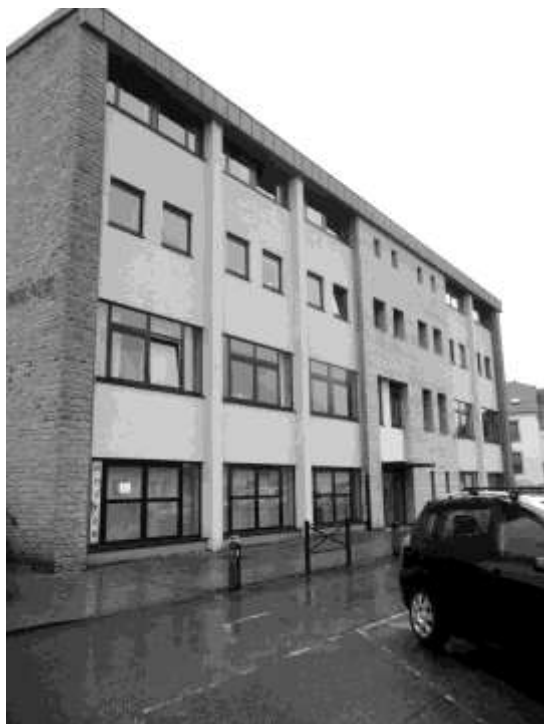
Le nouveau bâtiment, construit pour l'école professionnelle, tel qu'il se présente aujourd'hui ; il est occupé par l'IMP Institut de la Providence
