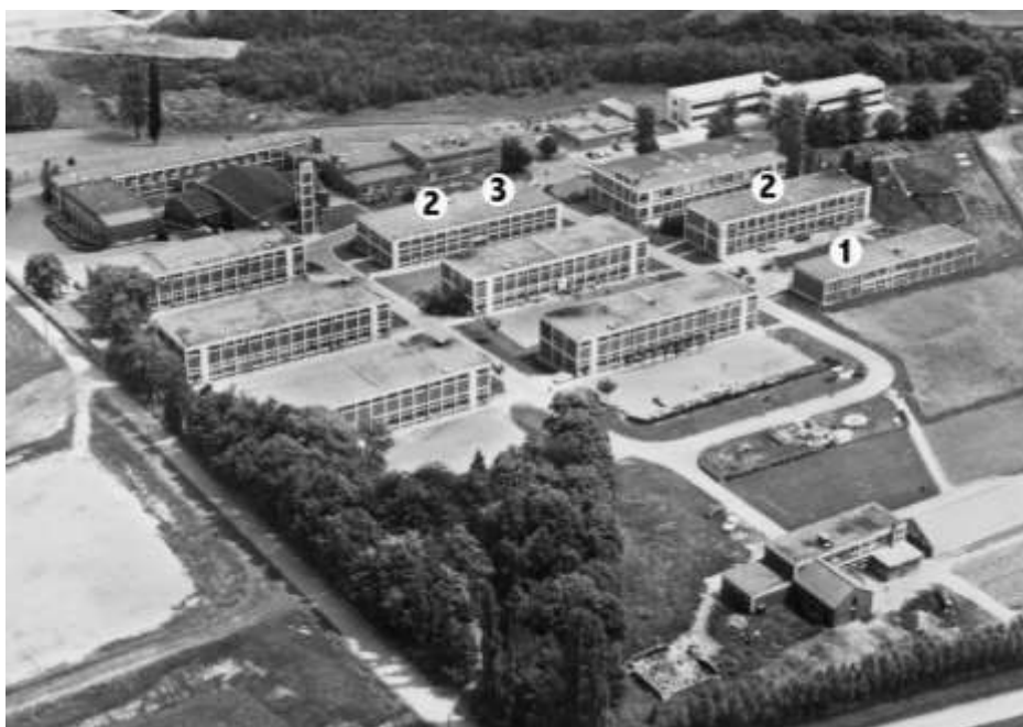
Vue aérienne de l'ensemble du site ; le pavillon 1 est la salle de gym ; les pavillons 2 étaient occupés par l'école secondaire pendant les premières années ; le 3 est le bâtiment de l'école aujourd'hui
