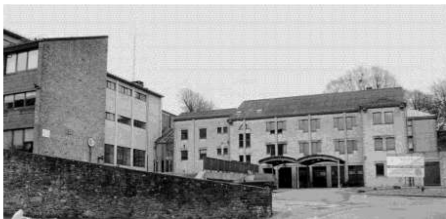
Les nouveaux bâtiments de l'ETB, rue de la Retraite à Bertrix
