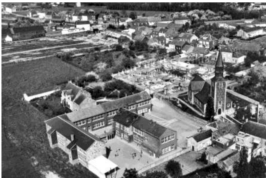
Vue aérienne d'Eghezée en 1965 : on aperçoit à l'avant plan l'église et, à sa gauche, les bâtiments des Instituts Saint-Joseph (primaire et secondaire) ; dans le fond, à droite, le terrain de la râperie et les premiers travaux de construction du Collège Saint-Hubert
