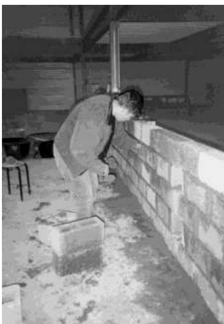
↳ Le hall vide et les premiers travaux d'aménagement
