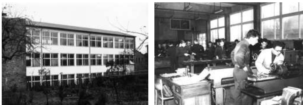
L'école technique, intérieur et extérieur
