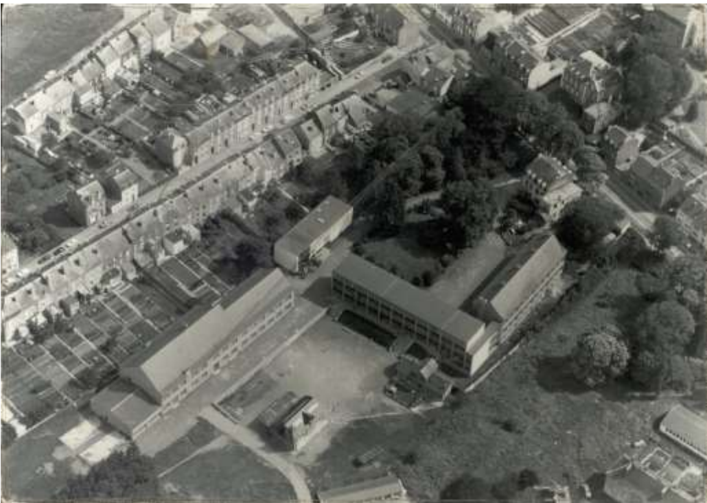
Vue aérienne du site d'Arlon
