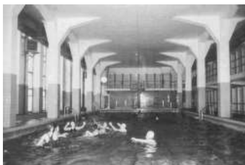
La piscine, dont la construction a démarré en 1949
