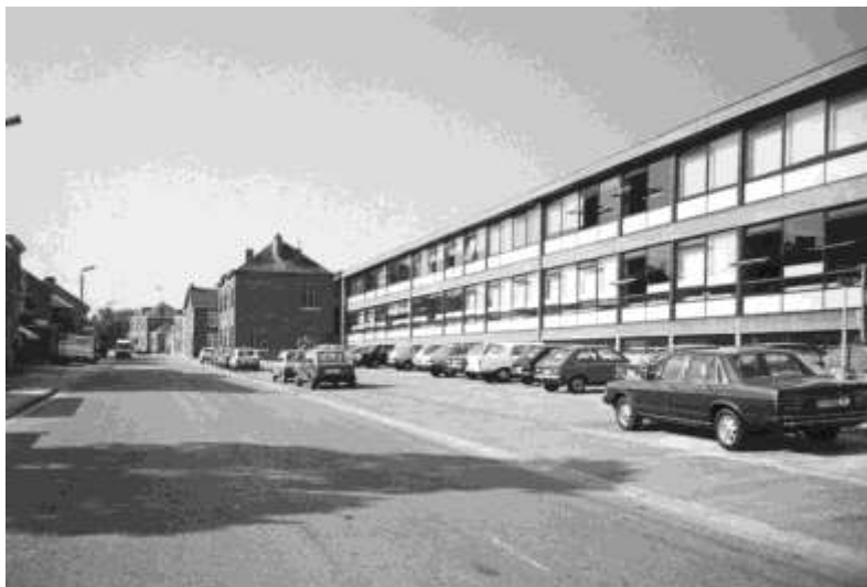
Les bâtiments du Collège Saint-Hubert avec, à gauche, les bureaux de la râperie transformés en classes et en laboratoires
