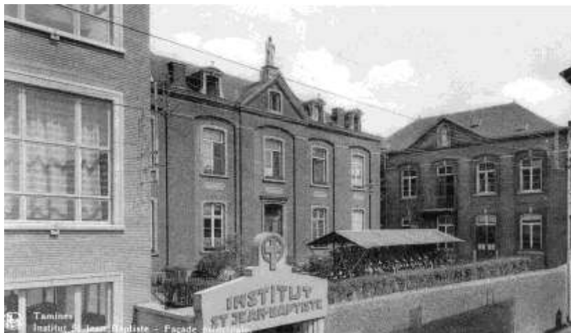
Les bâtiments le long de la rue du Collège où l'on découvre que le vélo avait encore une place importante dans la mobilité des élèves
