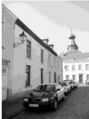
A gauche, le bâtiment qui fut occupé par l'école communale des Frères de 1840 à 1859 sur l'« aire » située devant l'église décanale
