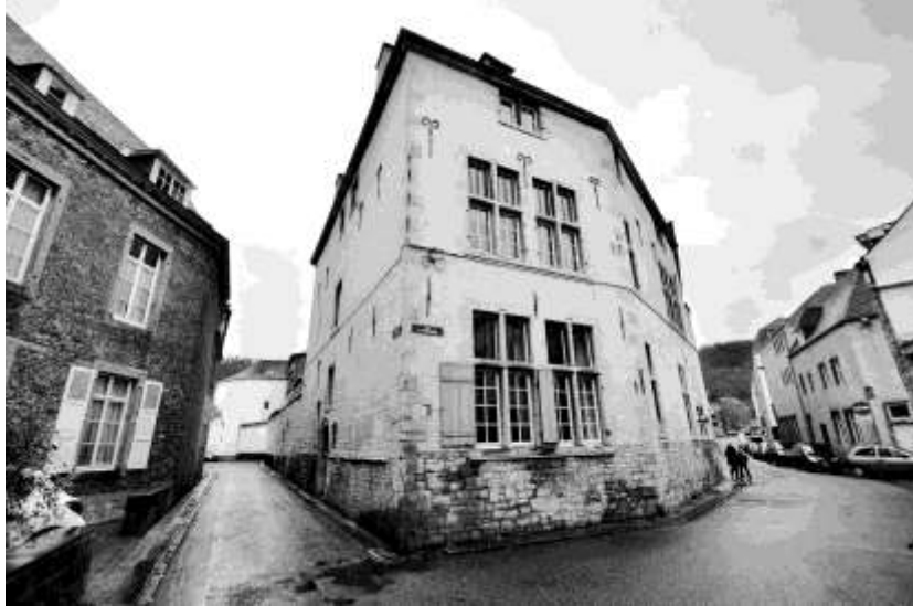
Le Bureau de l'Enseignement, à l'angle des rues de l'Evêché à gauche et du Séminaire à droite
