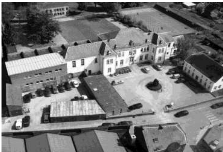
Vue aérienne du site du Voisin, avec à l'avant-plan à gauche les toits de la Bachée et au fond du parc, le Pavillon
