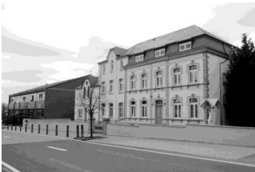
Les bâtiments actuels le long de l'avenue de la Gare
