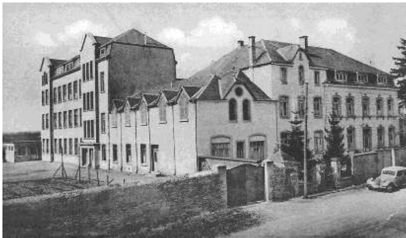
La première maison dans laquelle se sont installés en 1926 les Pères à Habay et, sur la gauche, le bâtiment (bloc II) construit entre 1936 et 1938
