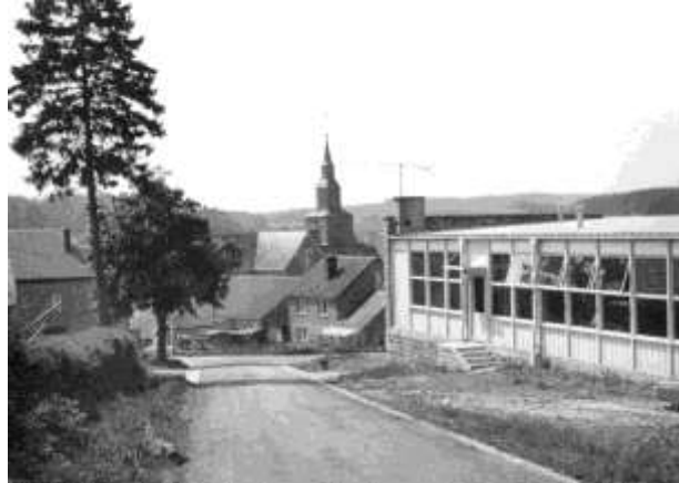
Le premier bâtiment de l'Institut le long de la rue de Robio
