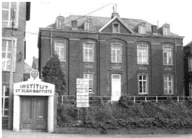
Le bâtiment principal de l'école à la rue du Collège
