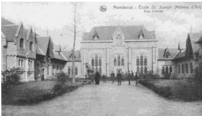
Le bâtiment de l'école avec les deux ailes déjà construites ; il deviendra en 1996 le centre d'accueil de l'abbaye de Maredsous
