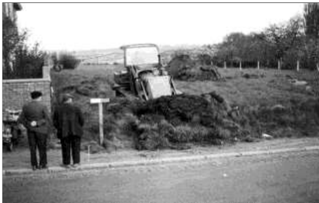
La future entrée de l'école au début des travaux en avril 1962
