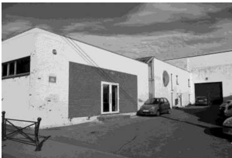
L'ancien garage Opel qui abrite le restaurant scolaire
