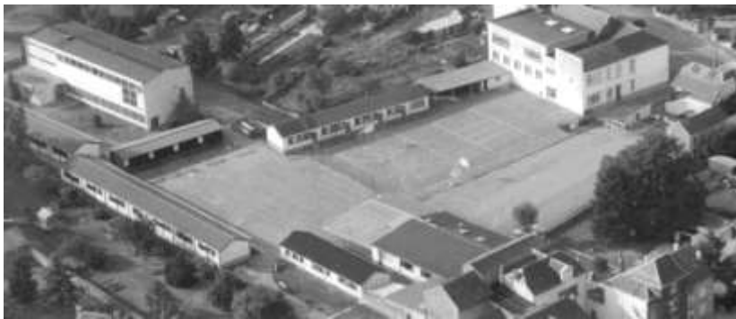
Les bâtiments actuels de la rue Lutgens à Athus
