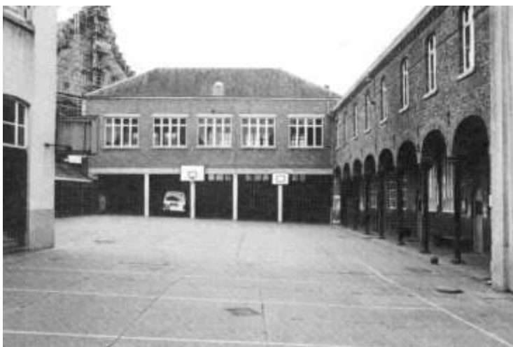
Ouverture de la porte cochère donnant sur la place Roi Albert et aménagement du préau sous la nouvelle salle de gymnastique.
