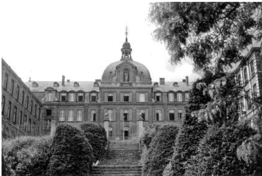
La partie centrale reconstruite
