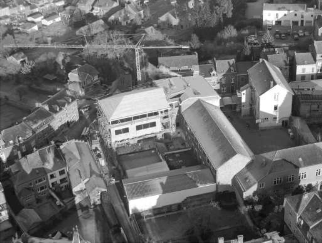
↑ L'implantation de Rochefort, en travaux début 2008
