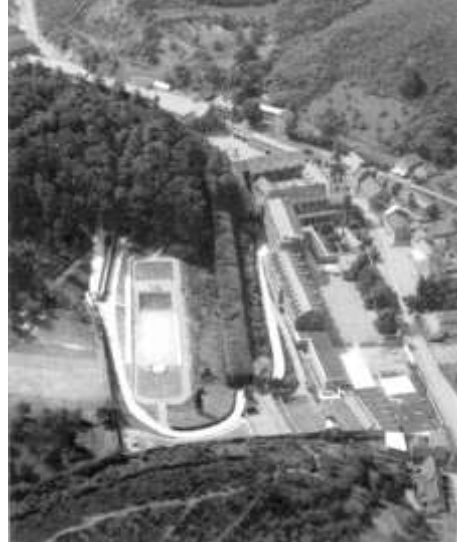
Vue aérienne depuis le nord ↑
